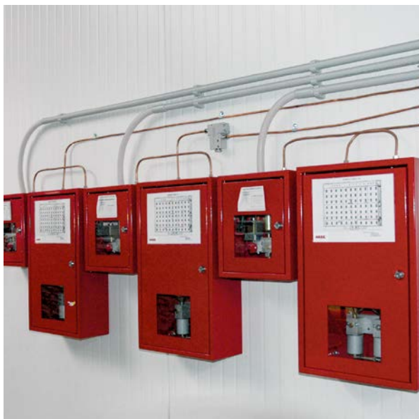
Rys. 1 Przykładowe zastosowanie pneumatycznych systemów sterowania oddymianiem
